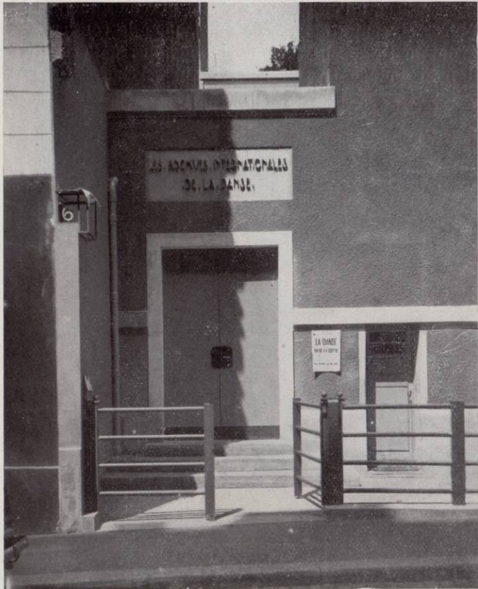
Entrée principale (Détail)
